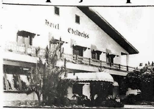
Vista parcial da fachada do Hotel Edelweiss, que tem estilo alemão
